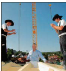
Bauherr Gerwin R. Platz schlägt den letzten Nagel auf dem Dachstuhl ein. Die Zimmerleute der Firma Kreutner klatschen Beifall.
