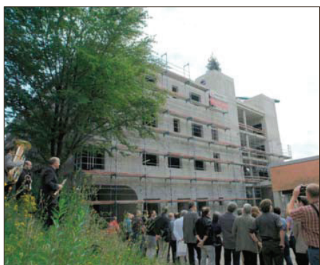
Traditioneller Richtspruch am Ergänzungsneubau des Kreiskrankenhauses: Hier entsteht ein Gemeinschaftswerk mit der Psychosomatik des ZfP. Foto: Michael Adams
